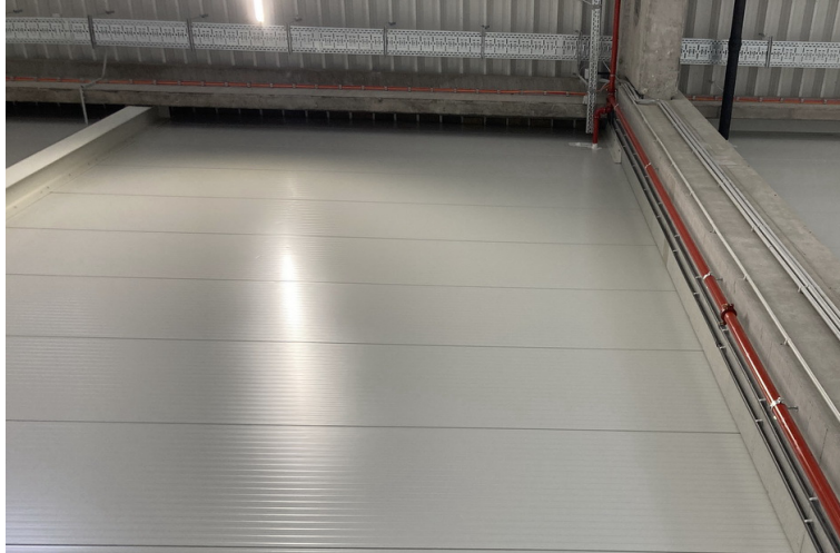
A lentről is látszó csőátvezetések tömítettek
