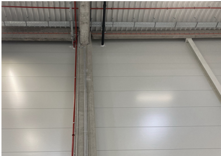
A lentről is látszó csőátvezetések tömítettek
